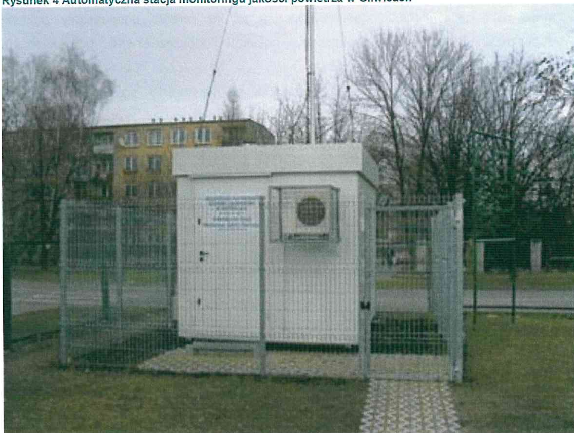
Rysunek 4 Automatyczna stacja monitoringu jakości powietrza w Gliwicach
