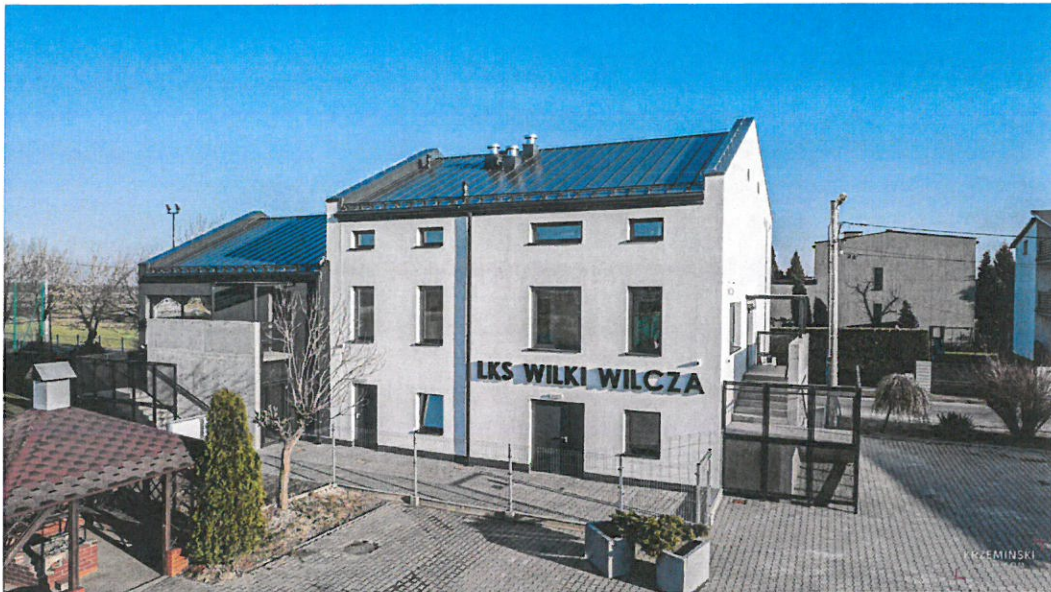
Budynek przy ul. Grzonki 13a
