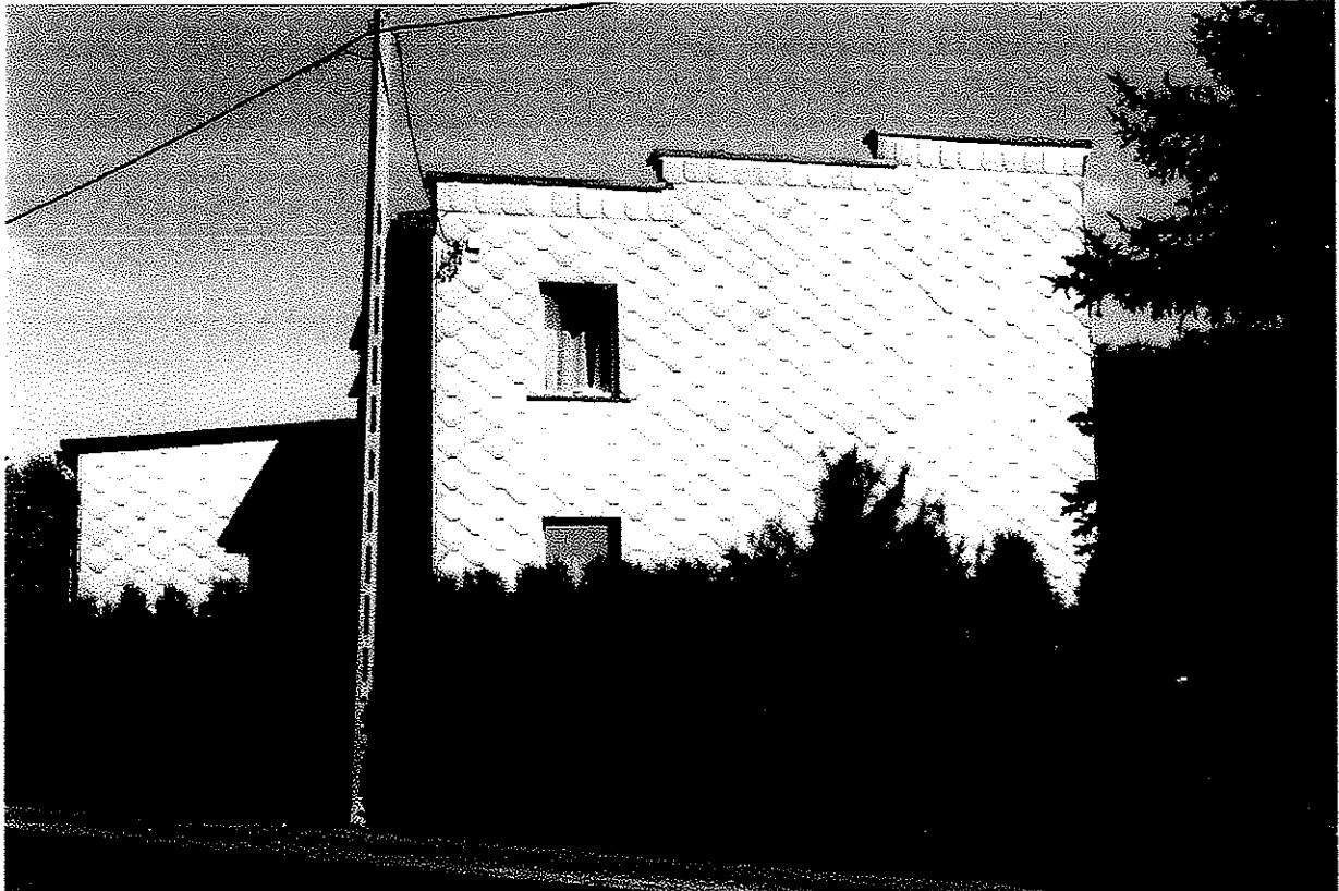
Rysunek 14 Elewacja pokryta płytami azbestowymi płaskimi (III stopień pilności)
